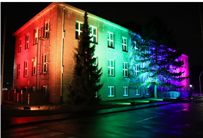
Foto (Evonik): Bekenntnis zu Vielfalt und Miteinander: Das bunt beleuchtete ehemalige Forschungsgebäude an der Feldmühlestraße in Lülsdorf.
