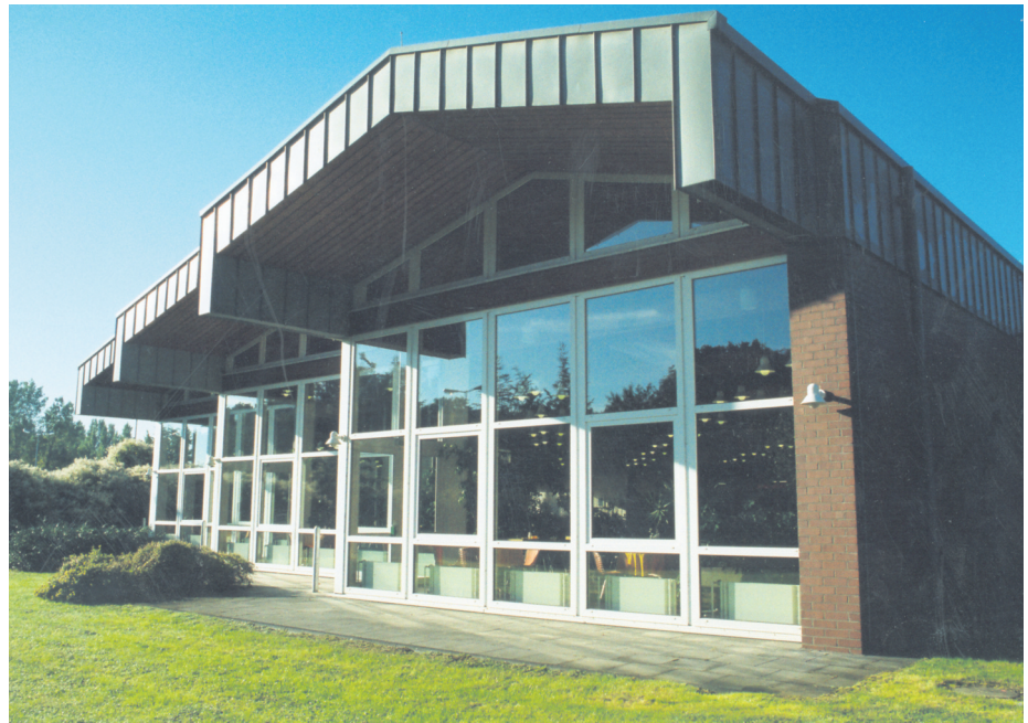
Mit dem Bau des „Neuen Kasinos“ wurde 1992 begonnen.
