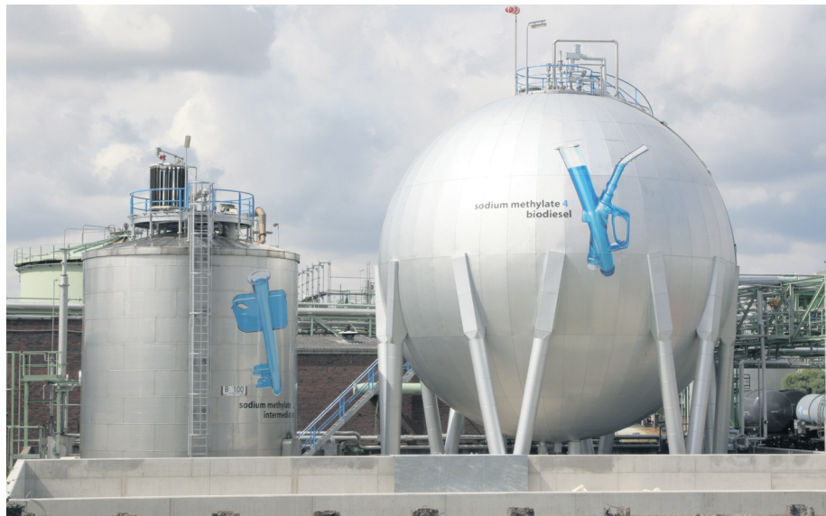
Alkoholattank in Lülldorf: Alkoholate werden bei der Umwandlung von Pflanzenöl in Biodiesel als Katalysatoren eingesetzt.
