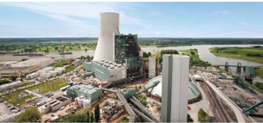
Steinkohlekraftwerk Duisburg-Walsum – Stand der Bauarbeiten im Mai 2009
