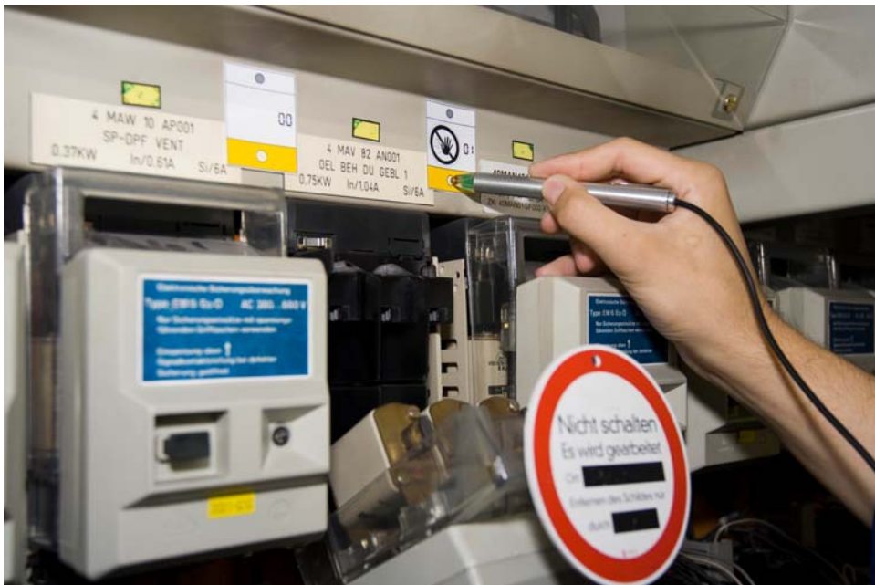
Einsatz der V-RFID-Chips von Evonik zur Anzeige des Freischaltzustands
